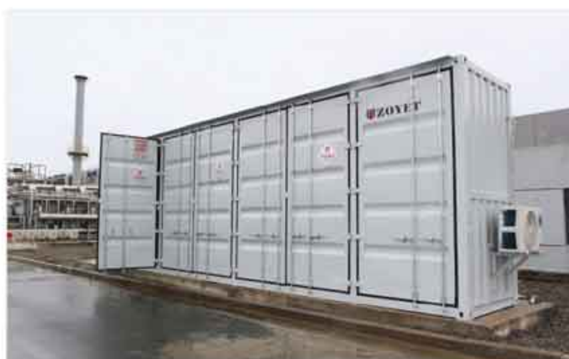
厚生新能源项目
