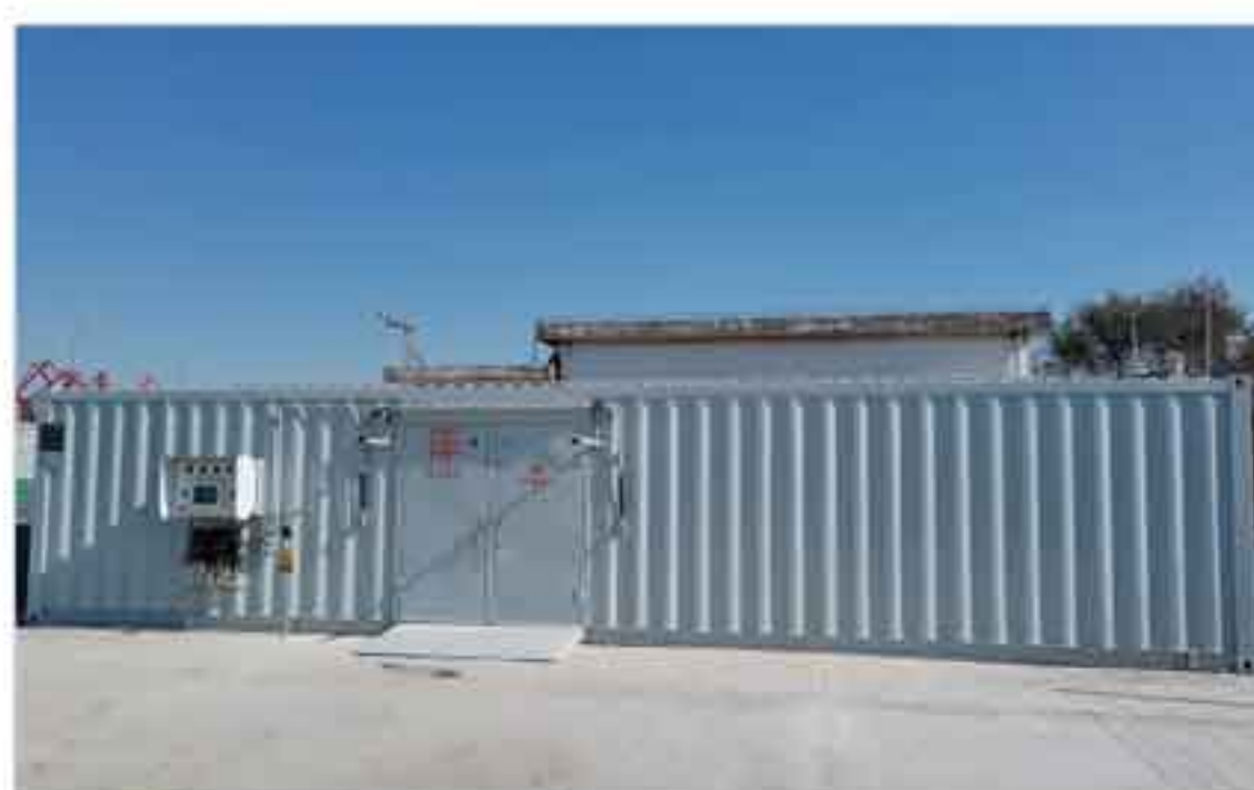
张家港港务局项目
