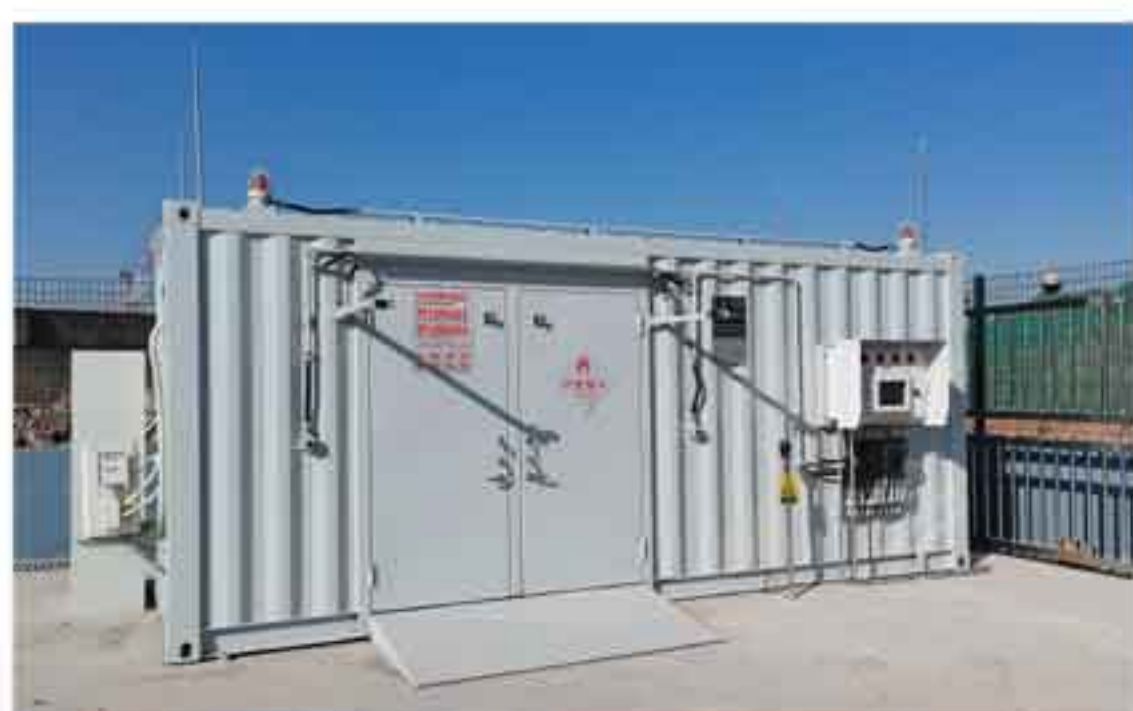
张家港港务局项目
